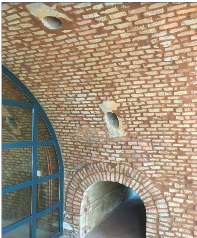
Fig. 5 - Bocchette per alimentare e “guidare” il fuoco nella ex-fornace al polo Navile dell’Università di Bologna
