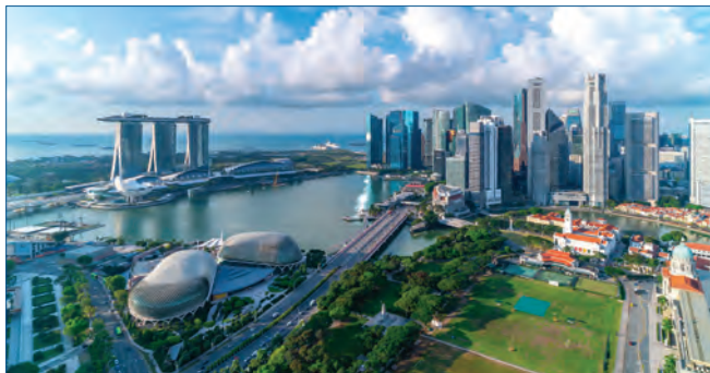
Fig. 5 - Per la posa del Marina Bay Resort a Singapore sono stati utilizzati gli adesivi innovativi delle linee Mapecem, Ultraplan, Granirapid e Ultracolor
