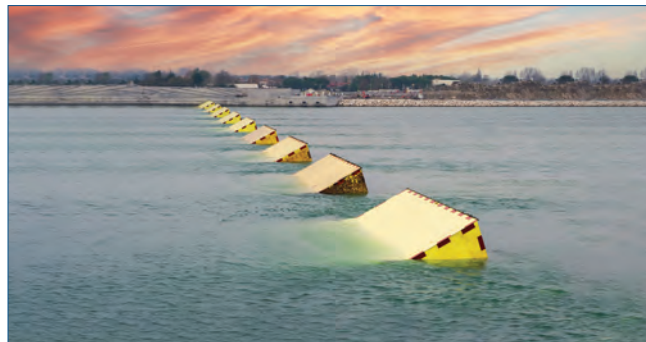
Fig. 6 - I cassoni di ancoraggio delle paratoie mobili del MoSE sono stati protetti con Mapeplastic, un composito polimero-cemento
