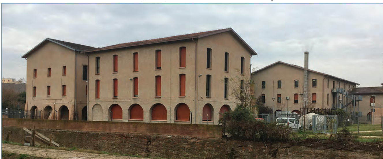
Fig. 1 - La fornace Gallotti, sede del Museo del Patrimonio Industriale di Bologna, e le sponde del canale Navile. Sotto l'ultimo portico a sinistra s'intravede la base della cupola del forno Hoffman di cui gli essiccatoi nei piani superiori sfruttavano il calore disperso
