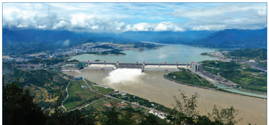
Fig. 4 - La Diga delle Tre Gole, la seconda diga più grande al mondo, sul fiume Azzurro, nella provincia di Hubei in Cina. Il calcestruzzo degli sfioratori di piena è stato realizzato con il superfluidificante Mapefluid X404
