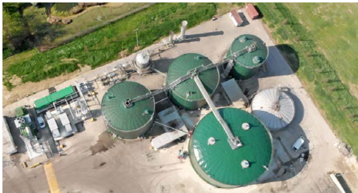
Tipico impianto di biogas
